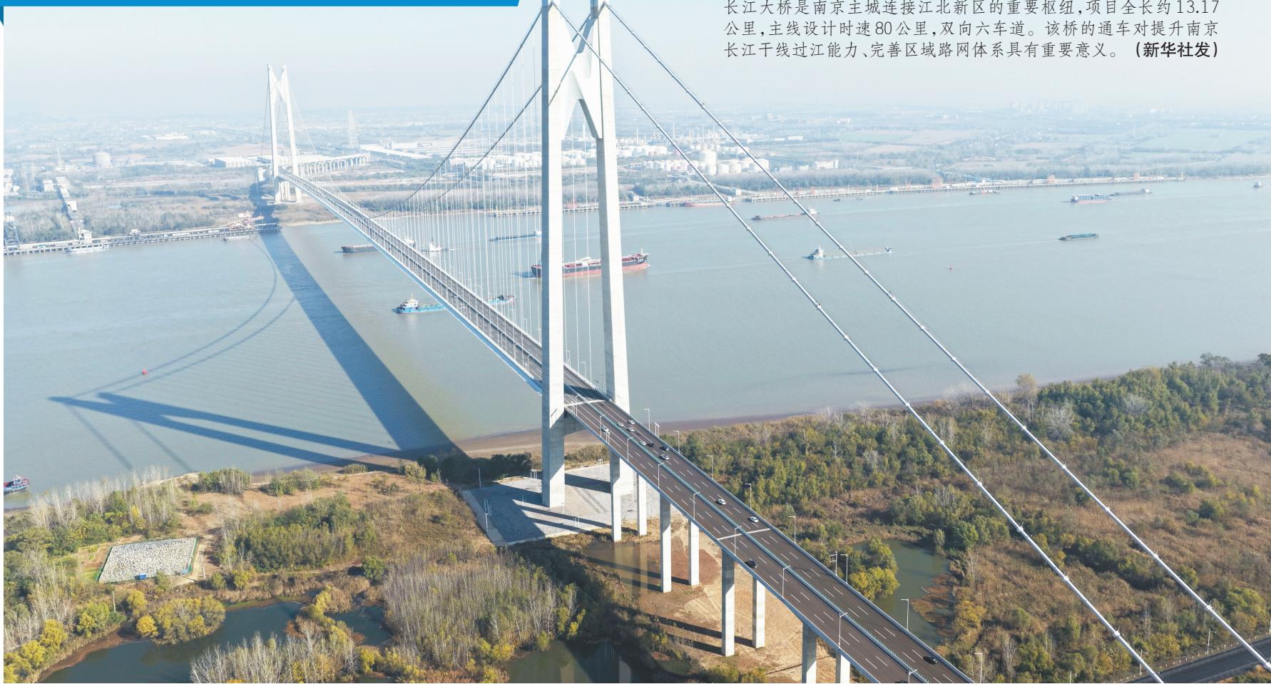
11月26日拍摄的南京新生圩长江大桥（无人机照片）。
