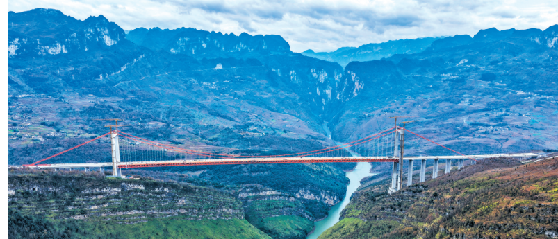
1月6日拍摄的主体工程已完工的安盘高速天门特大桥(无人机照片)。近日，贵州安(安顺)盘(盘州)高速天门特大桥主体工程顺利完工。天门特大桥是安顺至盘州高速公路的重要控制性工程，大桥全长1553米，桥面距峡谷水面约560米。(新华社发)
