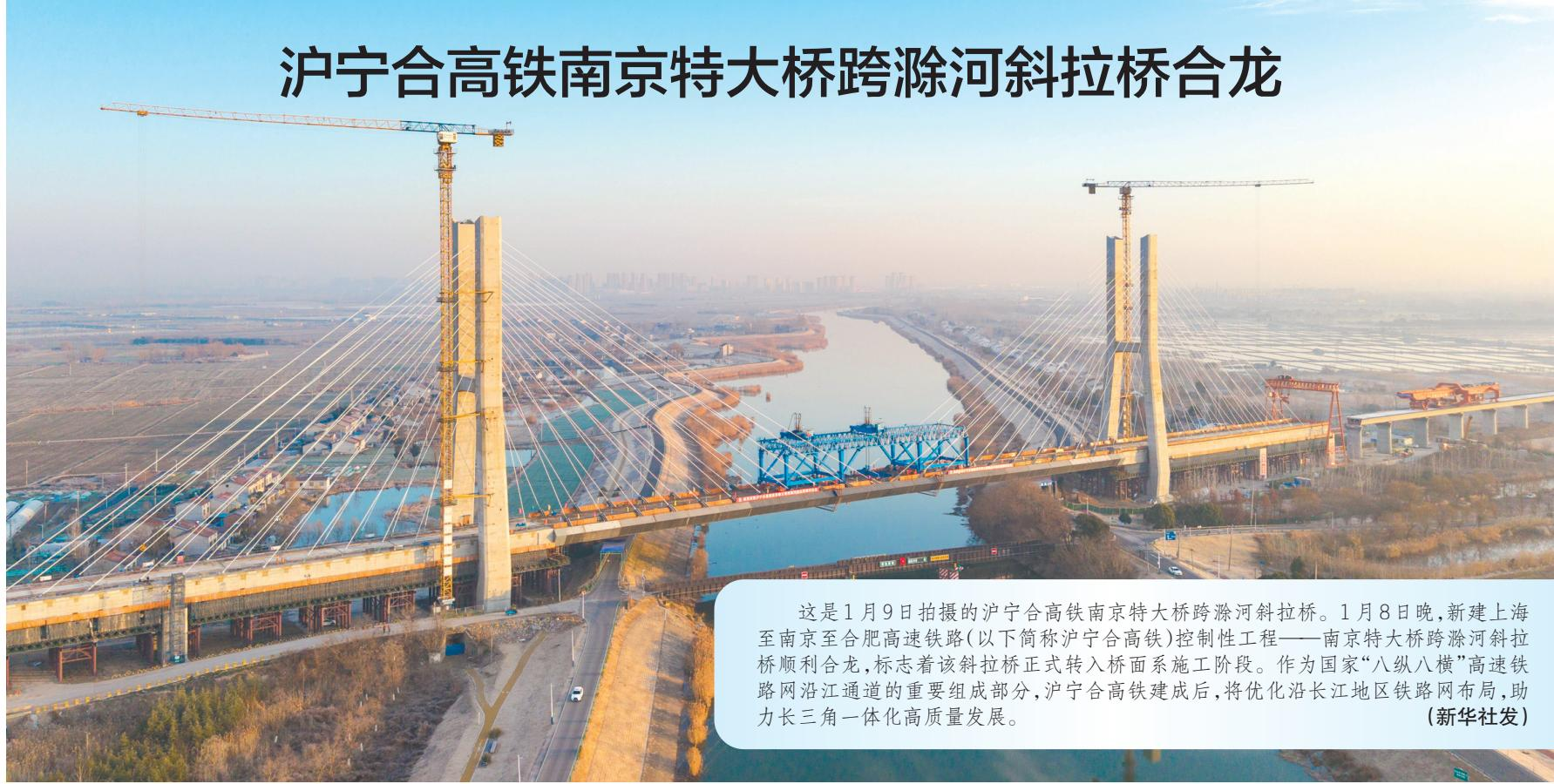
这是1月9日拍摄的沪宁合高铁南京特大桥跨滁河斜拉桥。1月8日晚,新建上海至南京至合肥高速铁路(以下简称沪宁合高铁)控制性工程——南京特大桥跨滁河斜拉桥顺利合龙,标志着该斜拉桥正式转入桥面系施工阶段。作为国家“八纵八横”高速铁路网沿江通道的重要组成部分,沪宁合高铁建成后,将优化沿长江地区铁路网布局,助力长三角一体化高质量发展。
