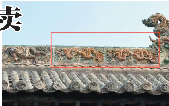
2026年3月9日，大皖新闻记者实拍夏禹神祠正脊琉璃现状。
