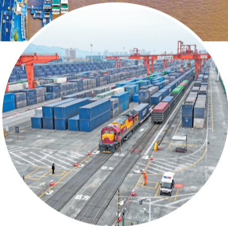
重庆国际物流枢纽园区。
