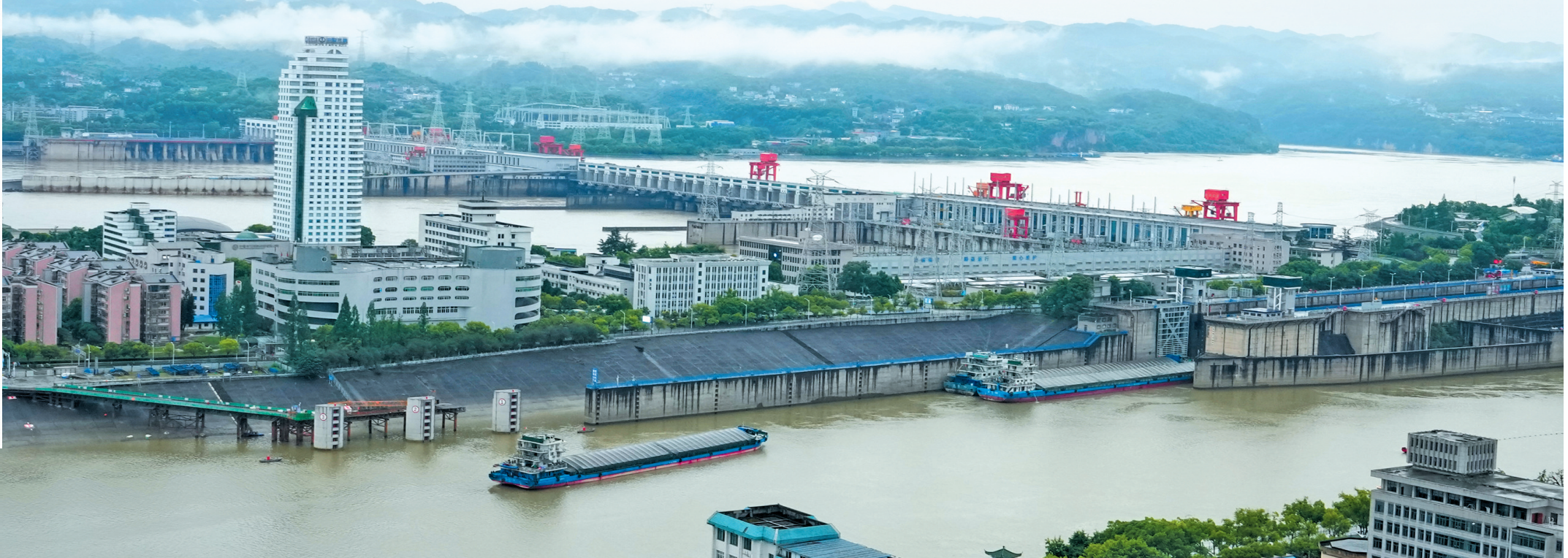
新建两线单级船闸，扩挖上下游引航道 船闸主体段全长400米
